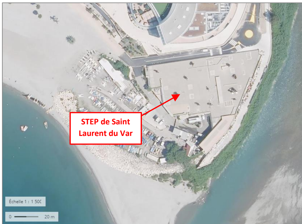
Figure 29 : Vue aérienne de la STEP de Saint Laurent du Var (source : GEOPORTAIL)
